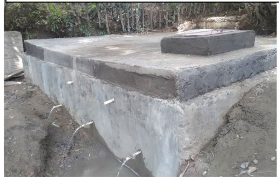
De nieuwe watertank op plaats van de oude
