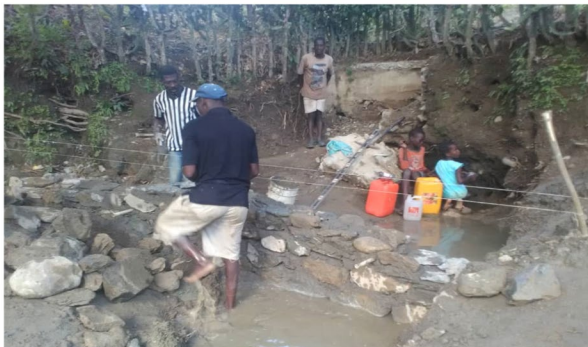
De bouw nieuwe watertank door de bevolking
